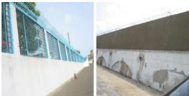
Figure 25.3: Détails de la clôture périphérique du Port de Dakar.
